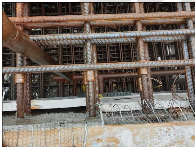
اجرای لوله‌های پس‌سرمایش در فونداسیون
