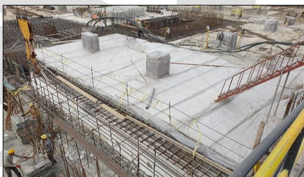
عایق‌کاری حرارتی فونداسیون حجیم به ضخامت ۳ متر به منظور محدود کردن مقدار گرادیان حرارتی
